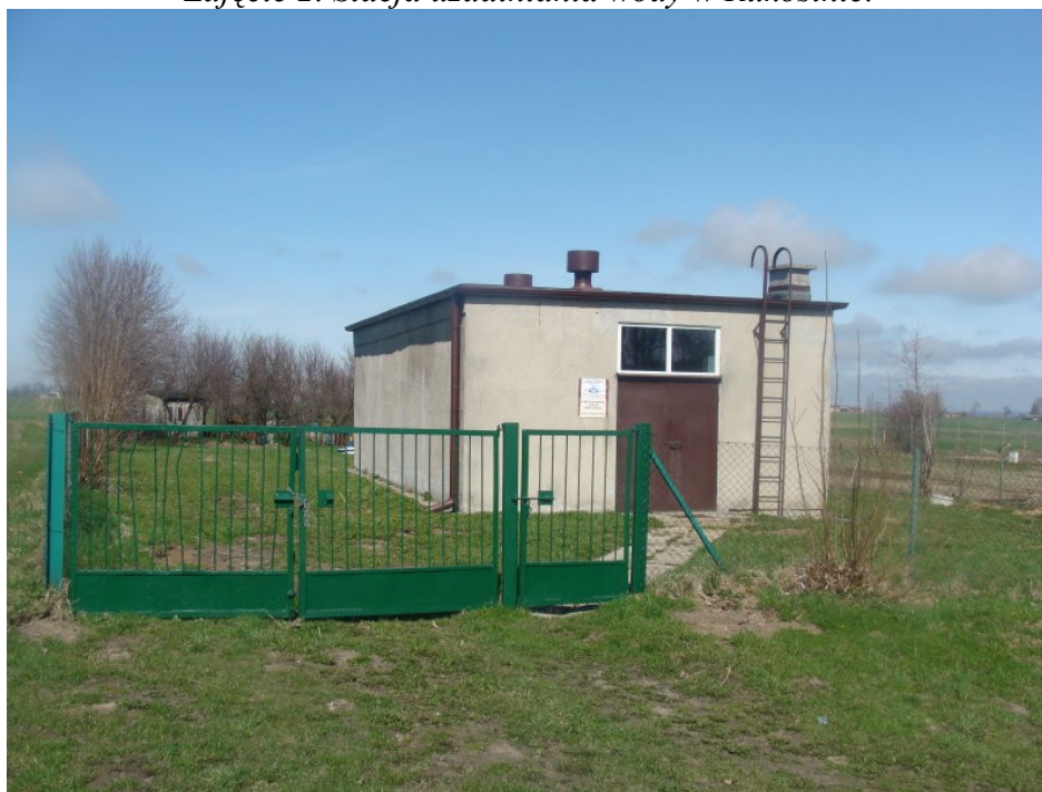
Zdjęcie 2. Stacja uzdatniania wody w Rukosinie.
